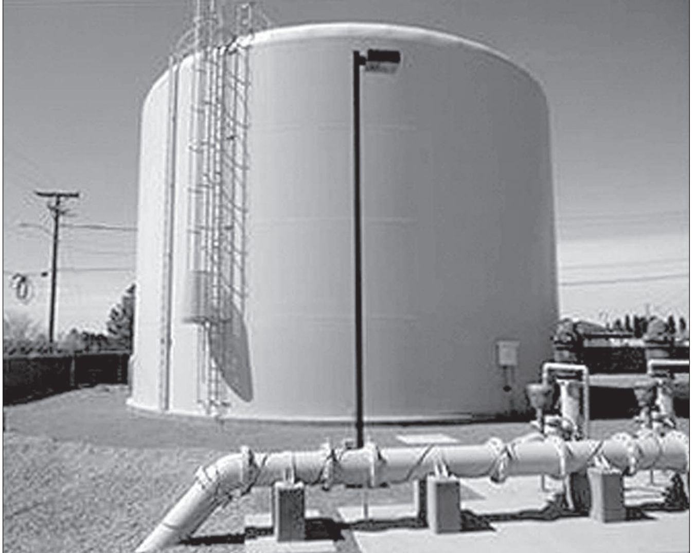
– Photo courtesy El Paso Water
