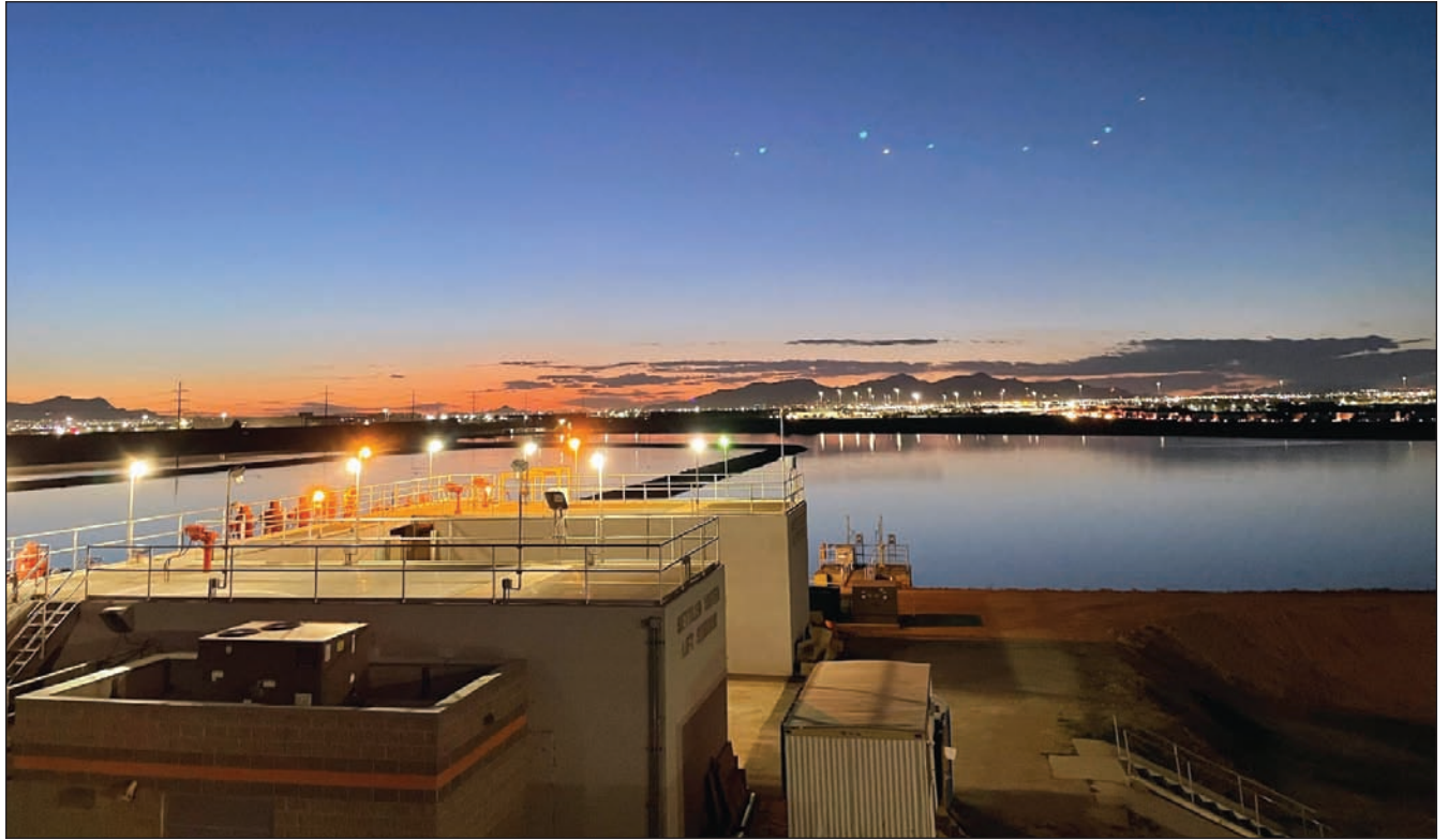
– Photo courtesy El Paso Water
